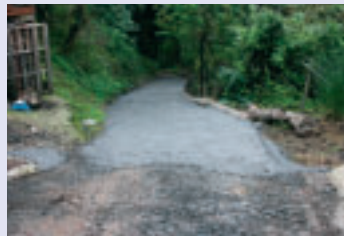
Sistemazione manto stradale strada Roletto Rocca (Cascina Rocca)
