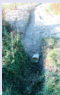
Canalizzazione acque meteoriche strada Mangialasino Braia (Casa Briola)
