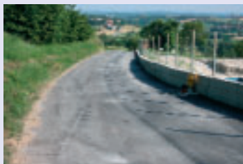
Asfaltatura strada Ortazzo
