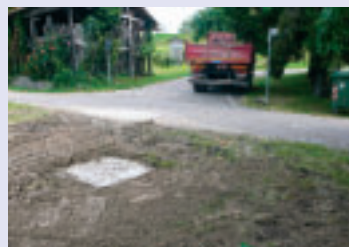
Sistemazione acque meteoriche e fosso pericoloso Frazione Cocconito
