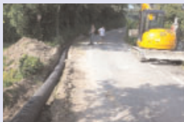
Sistemazione acque meteoriche frazione Foino
