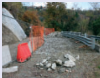
Lavori di ripristino e allargamento curva pericolosa in strada Valle
