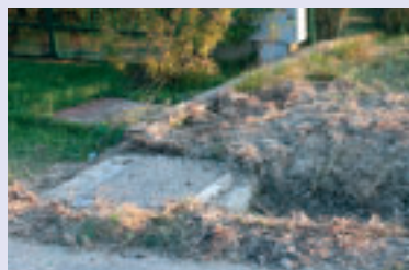
Sistemazione tombino salto acque meteoriche strada Ortazzo
