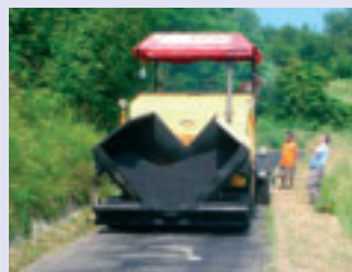
Asfaltatura strada Vai
