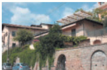
Posizionamento di gazebo per scuola materna
