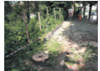
Consolidamento scarpata viale di Corso Pinin Giachino
