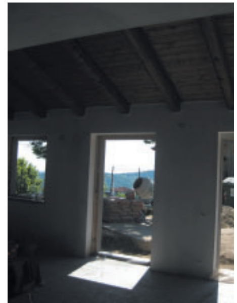
Ultimi lavori di ampliamento della Scuola Materna - 3° lotto
