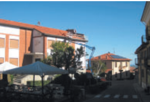
Verifica tetti edifici pubblici danneggiati a seguito della grandinata del 5 Agosto
