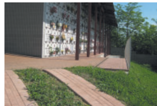
Lavori al Cimitero del Concentrico
