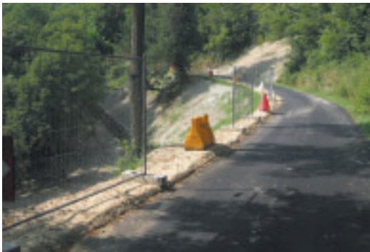
Sistemazione movimento franoso in Strada Cocconito - Pietra
