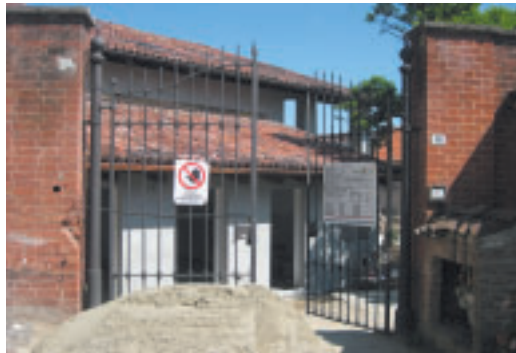
Lavori di ampliamento Asilo Comunale
