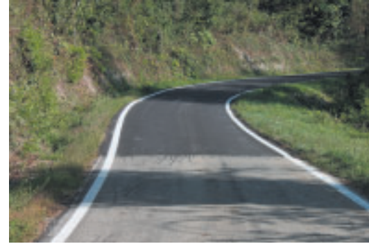
Nuovi asfalti su oltre 9,5 Km di strade
