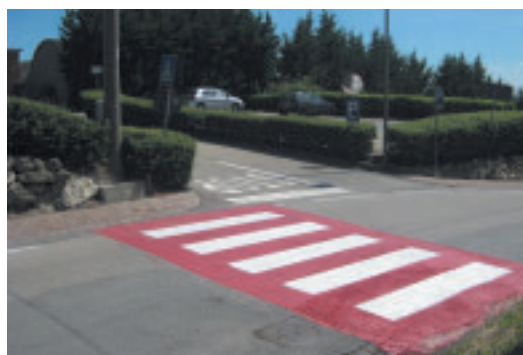
Realizzazione traversamenti stradali
