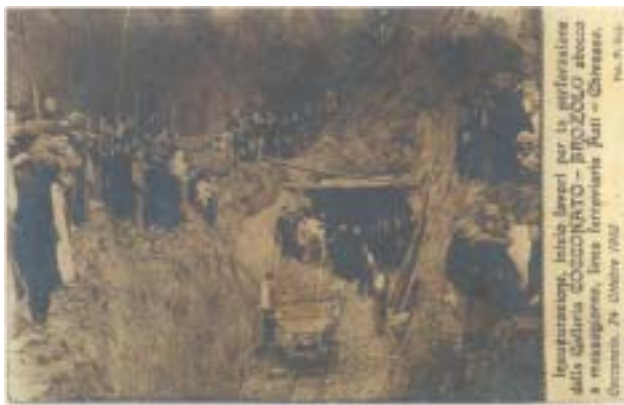
Inaugurazione inizio lavori di perforazione della galleria Cocconato-Brozolo, 1910. (foto fornita da Raffaella Conti)
