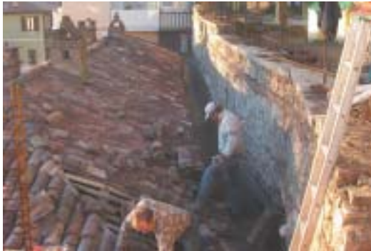
Sradicamento edera sul muro Asilo e revisione del tetto di casa Babilano
