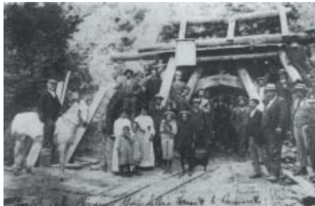
Costruzione della galleria Cocconato-Brozolo: foto ricordo davanti all'imbocco da Cocconato
