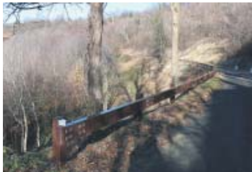
Posizionamento guard rail Strada Pietra in Frazione Cocconito
