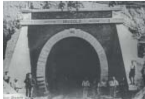
Imbocco da Brozolo della galleria Cocconato-Brozolo, 1912
