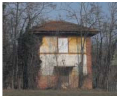
Il casello al passaggio a livello sulla strada per la borgata Rollegrossa
