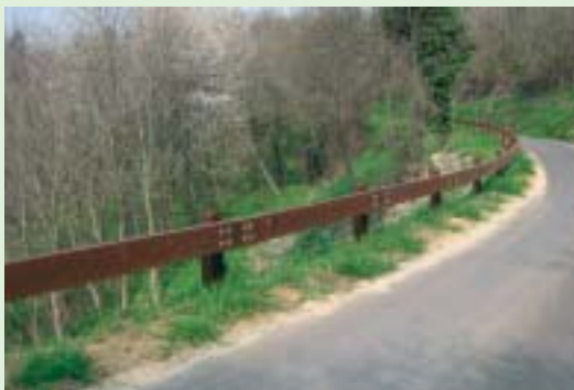
Installazione guard rail a Cocconito
