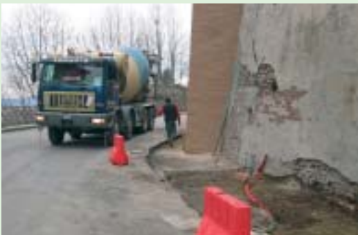
Lavori muro asilo
