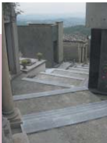
Lavori di rifacimento scalinata al cimitero del concentrico.
