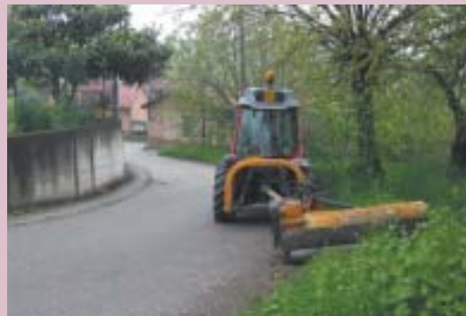
Lavori di manutenzione strade
