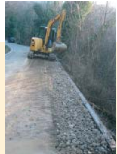
Lavori di contenimento frana su strada Spagnolino Solza.
