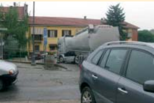
Viabilità strada del Concentrico, prima dei lavori.
