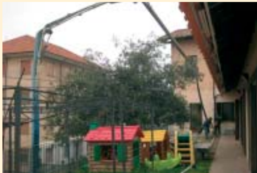
Lavori di adeguamento dell'Asilo nido.
