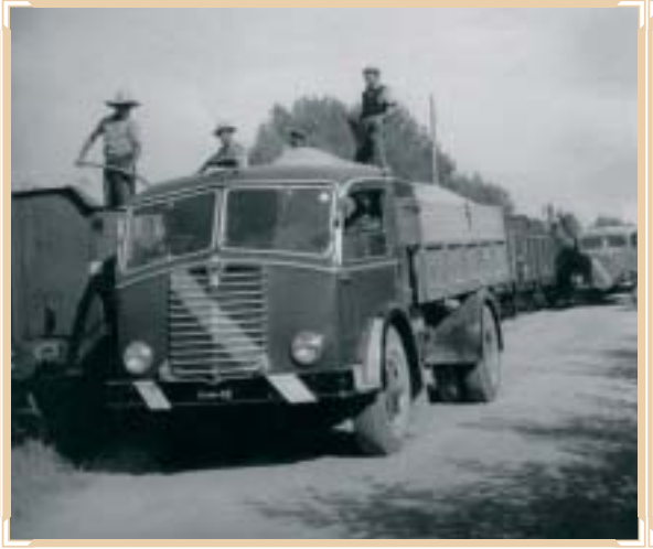
Stazione di Lauriano, 1958. Scaricamento a mano della loppa (scoria d'altoforno) dai carri ferroviari e caricamento sull'autocarro Fiat 680 N per il trasporto nel vicino cementificio. In piedi sul cassone del camion Maggiorino Viarigi, contitolare con il fratello Antonio e Cesare Ortalda di una ditta di autotrasporti.
