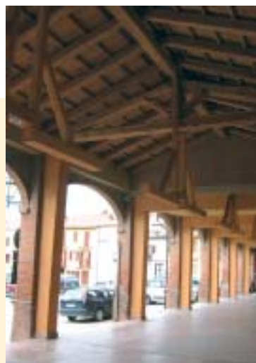
Ristrutturazione Tettoia di Piazza Giordano.
