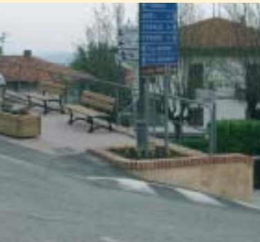
Fermata bus strada del Concentrico, dopo i lavori.
